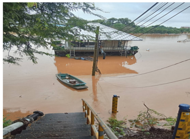
จุดสูบน้ำดิบแรงต่ำ หน่วยบริการตรอน
