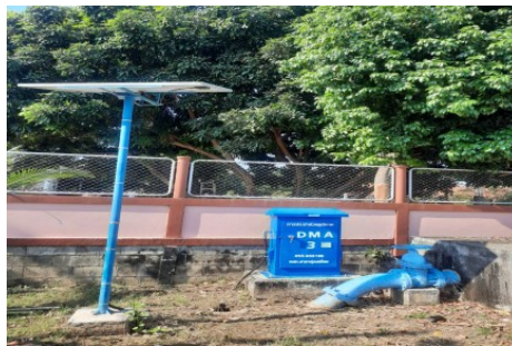
การใช้งาน Solar Cell ในระบบวิเคราะห์การจ่ายน้ำ
