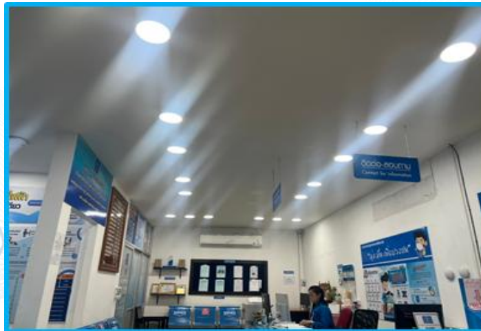
สำนักงานเลือกใช้หลอดไฟ แบบLED
