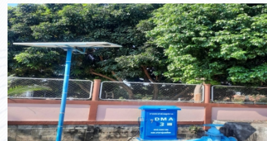
การใช้งาน Solar Cell ในระบบบิโเคราะห์การจ่ายน้ำ
